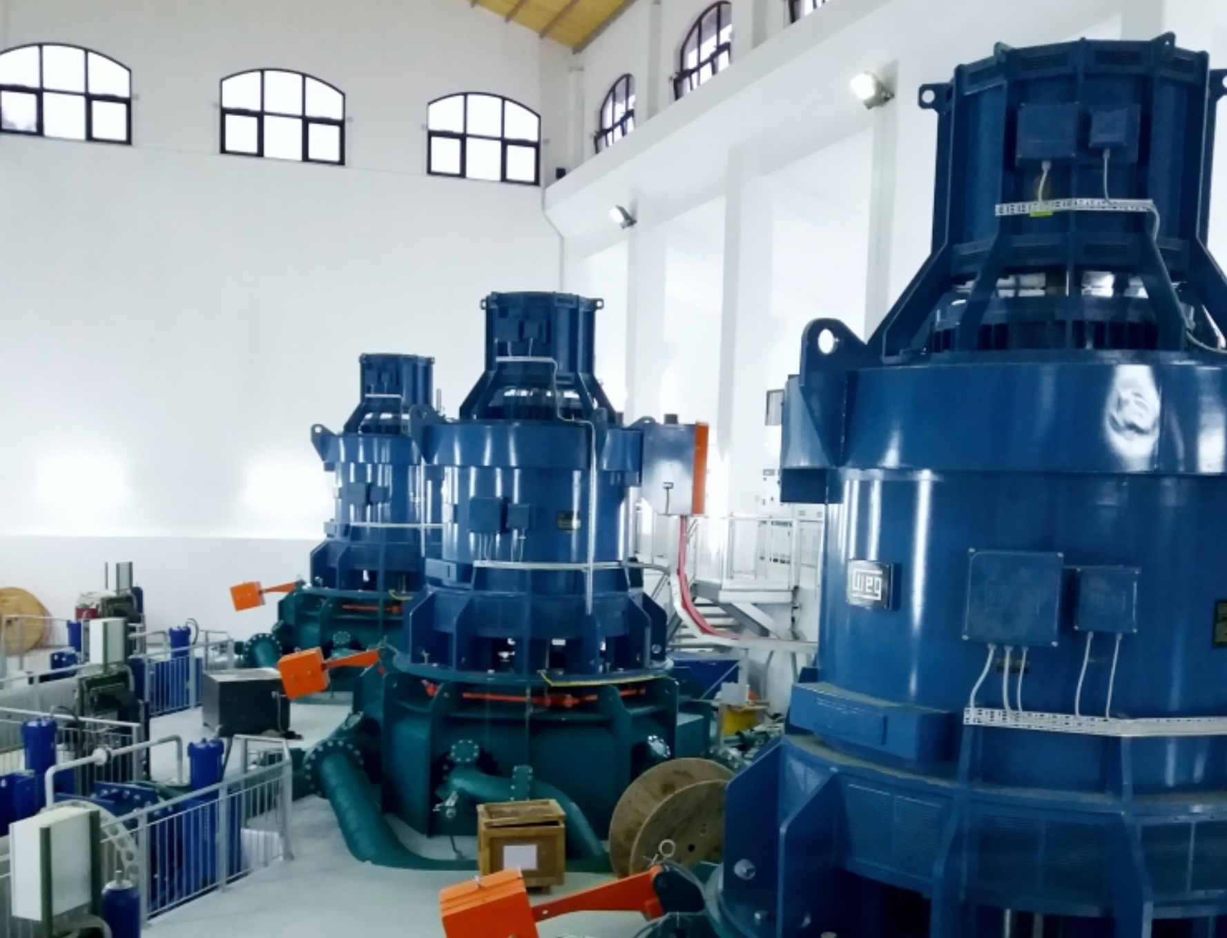
HIDROCENTRALI “PREDHA” NË LUMIN URAK BURREL. FUQIA 20 MVA PROJEKT I NËNKONTRAKTUAR NGA KOMPANIA ITALIANE SCOTTA
